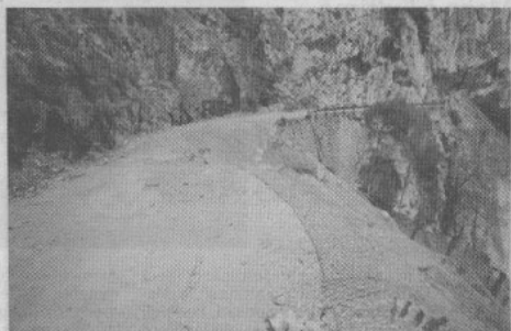
Un tratto della vecchia Ponale dopo la frana del '99
