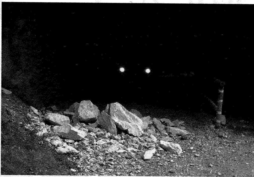
La frana di circa un metro cubo che si è staccata nei pressi della "galleria 4" della Ponale
