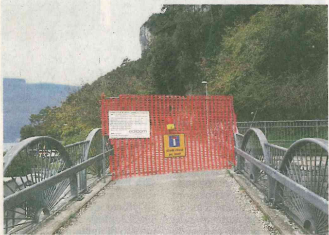
Il sentiero della Ponale è stato chiuso ieri: oggi il via ai lavori
