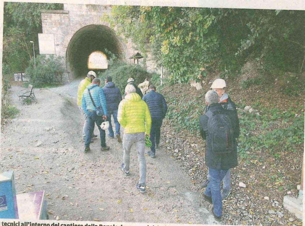
I tecnici all'interno del cantiere della Ponale dove sono iniziati i lavori di messa in sicurezza (foto Galas)
