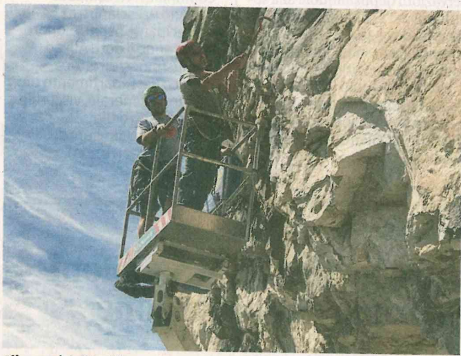
Gli operai della Edilcom al lavoro sul sentiero della Ponale
