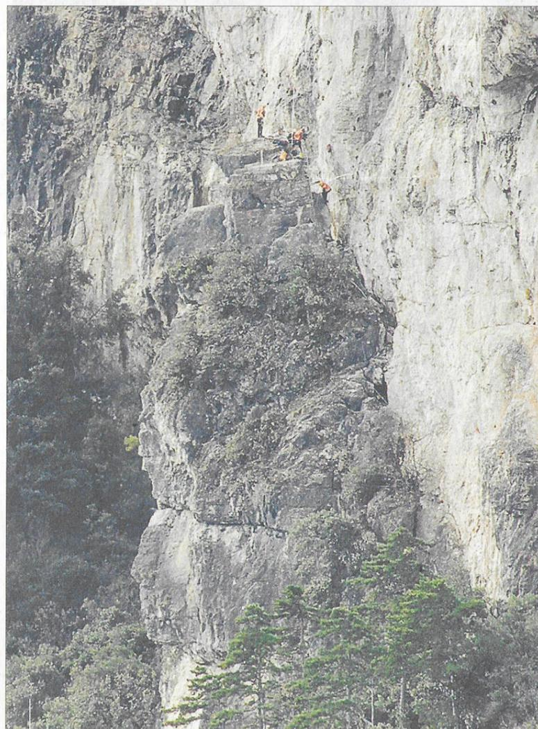
Tecnici ed operai durante la sistemazione delle cariche esplosive lungo il perimetro del torrione da abbattere (Fotoshop Professional)
